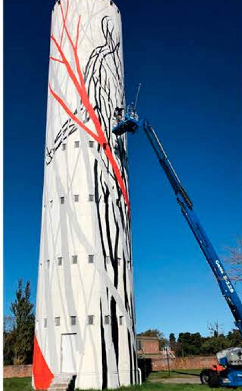
Plataforma telescópica Genie S-125 realizando trabalho de pintura em Montevideo – Uruguay
