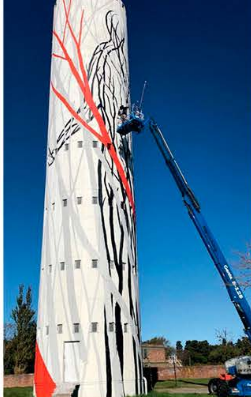
Plataforma telescópica Genie S-125 realizando trabajos de pintura en Montevideo - Uruguay
